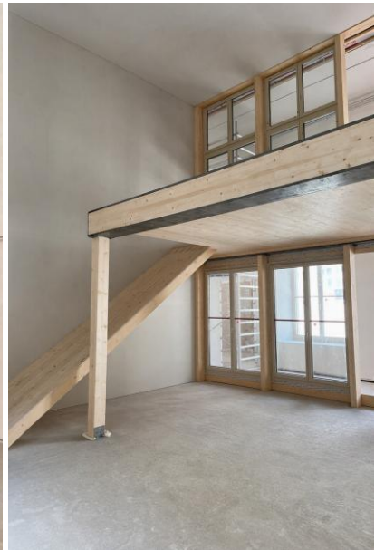
Raum im Umbau (August 2026)
