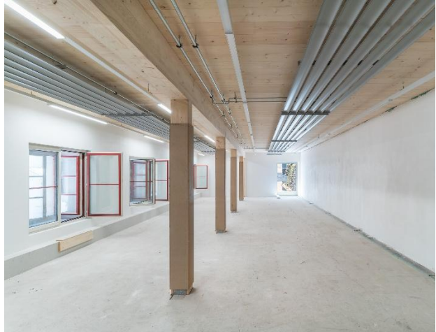
Raum W/01/01 im Umbau (August 2026 – Bild: Martin Zeller)
